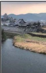
福知山大堤防は明智光秀が造らせた堤防をもとに明治42年に完成した堤防です。この堤防は昭和2年の北丹後地震により各所に亀裂や陥没が生じ、復旧の際にドイツ製鋼矢板やコンクリートを用い、強固な堤防に改修されました。担当者の名をとって岩沢堤と呼ばれ、今も福知山市街地を水害から守っています。
