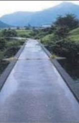
由良川には潜り橋が9つ存在します。潜り橋は増水時に橋がそのまま水没する橋です。由良川は洪水が多いので潜り橋があるのだと思われます。普段は生活道路として使用されていますが、沈んだときにゴミが引っかかるないように丸い橋脚になっていたり、欄干がなかったりして、普通の橋とは少し違ったつくりになっています。
